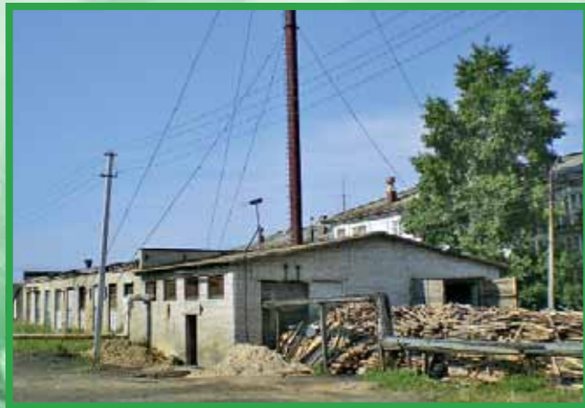
Котельная д. Андреевская
