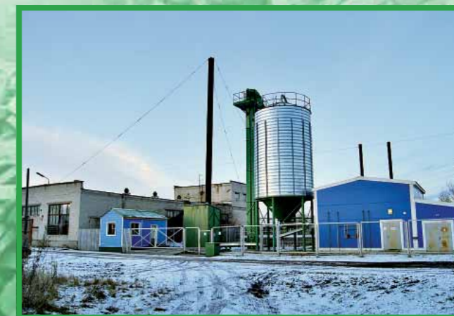
Котельная д. Луговое
