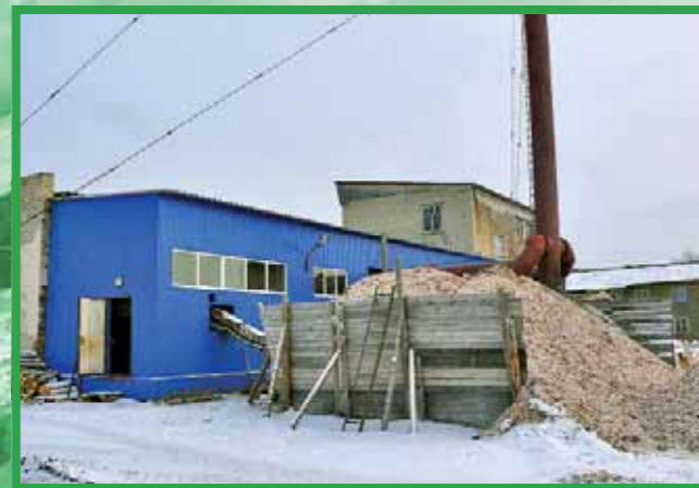
Котельная п. Березник
