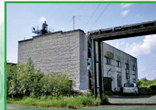
Котельная д. Мошинская
