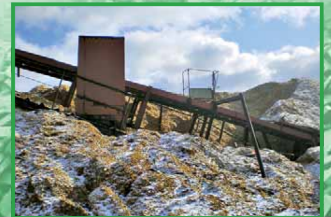
Котельная п. Луговецкий
