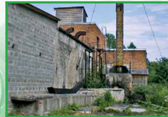
Котельная в г. Каргополь
