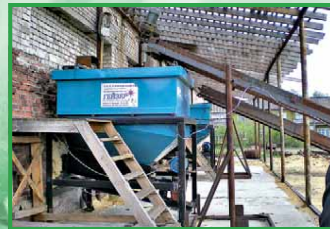
Котельная п. Березник
