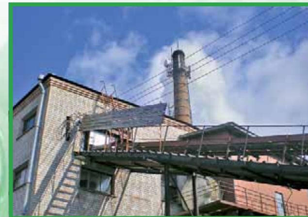
Котельная п. Луговецкий
