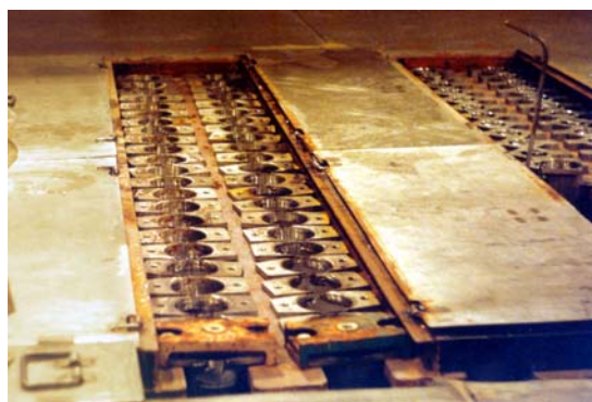
Неуплотненная схема хранения ОЯТ.
