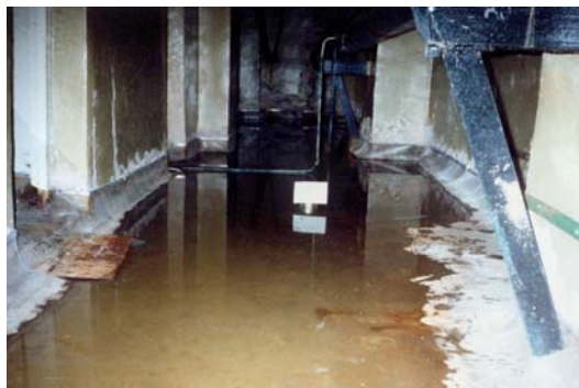
Грунтовые воды в хранилище отработавшего ядерного топлива (ХОЯТ).
