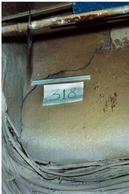
Дефект несущей конструкции зала хранения вызвал трещину.
