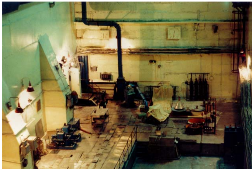
Зал перегрузки: на переднем плане видны шахты для чехлов с ОЯТ, установленных в бассейне перегрузки. Слева размещается каньон бассейнов передаточный (закрит панелями).
