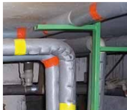
Утепление трубопроводов
