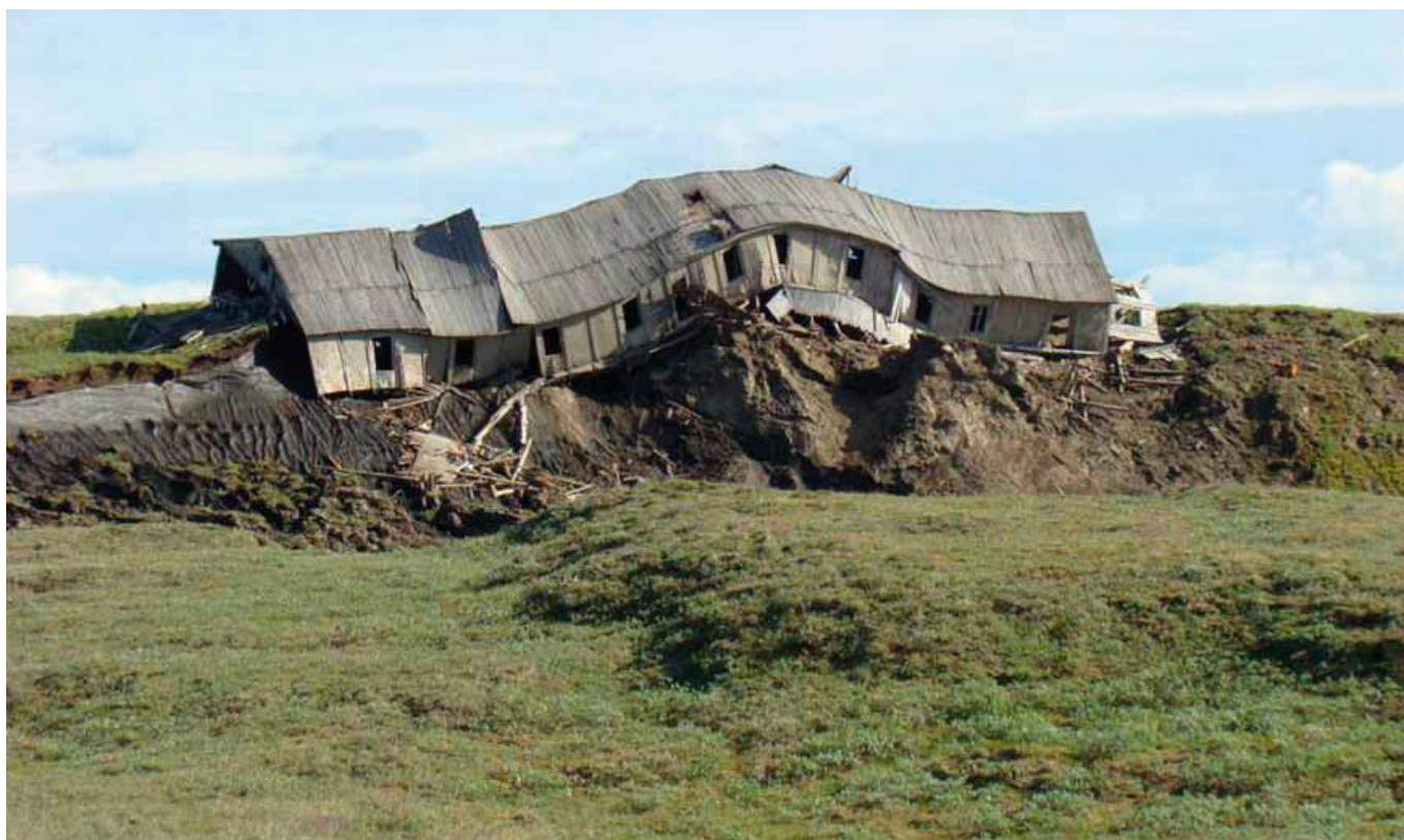
Здание военной части, расположенной в низовьях Енисея, сильно пострадало от вытаивания подземного льда.
