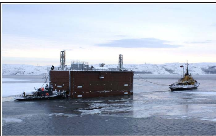
Морская транспортировка и установка экспериментального наплавного энергоблока в проектное положение в створе Кислогубской ПЭС
