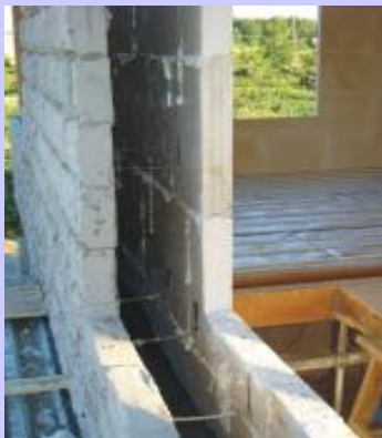
Несъемная опалубка + монолитный пенобетон
