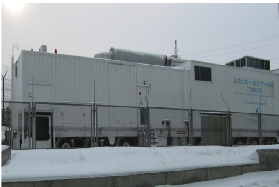
Рис. 2.3. Передвижная аварийная дизель-генераторная станция Нововоронежской АЭС
