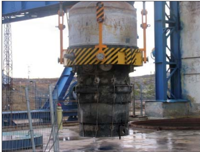
Перенос реактора с кантователя на стенд
